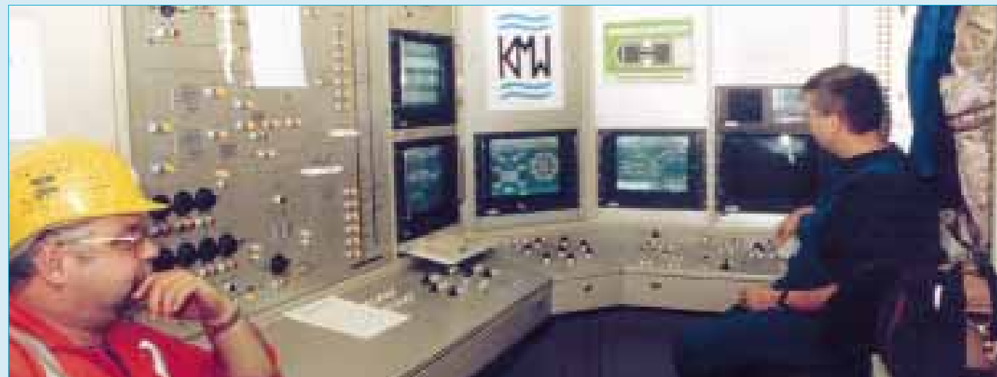
De besturingscabine in de TBM
