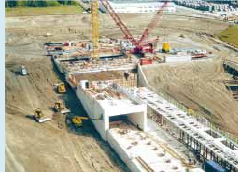
Bouwen van de tunneltoerit in Zeeuwsch-Vlaanderen
