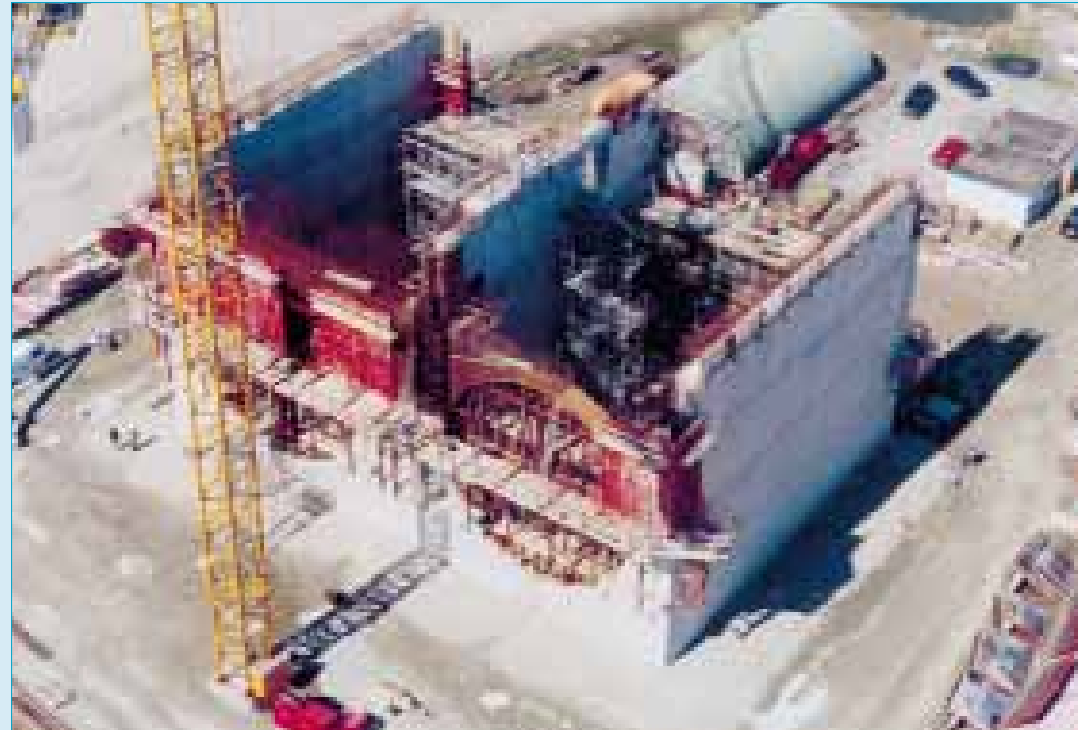
Bouwen van de tunneltoerit op Zuid-Beveland
