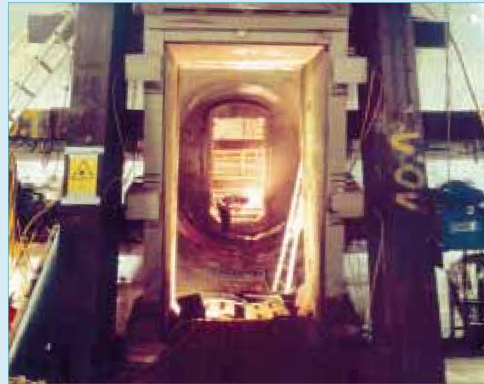
Een uitgegraven dwarsverbinding
