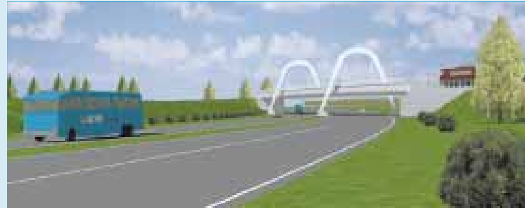
De hangtrogbrug bij de toeleidende weg in Zeeuwsch-Vlaanderen
