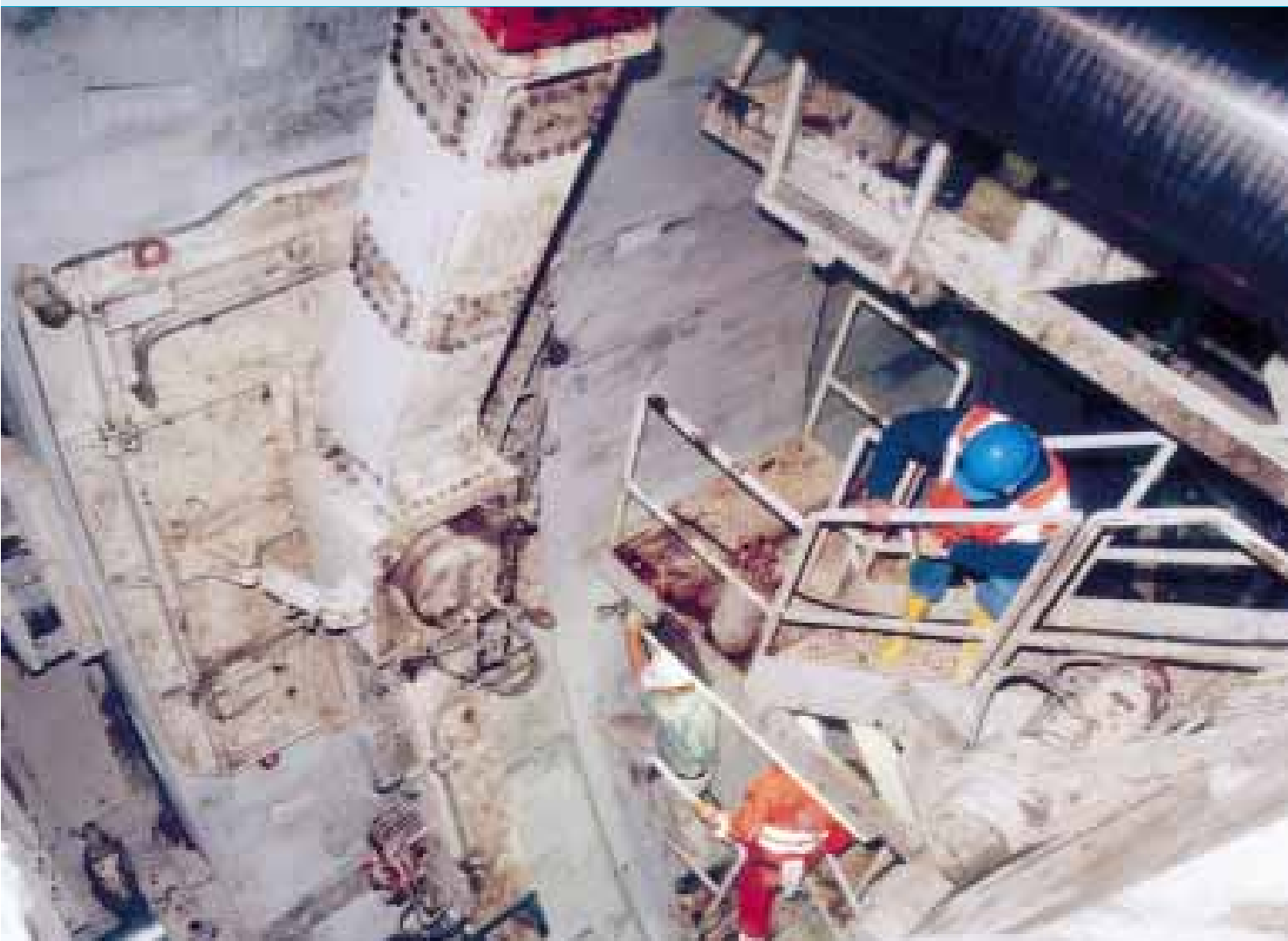
De erector plaatst een tunnelsegment
